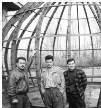
ساخت گنبد فلزی مسجد لنگرود، سال ۱۳۷۵
